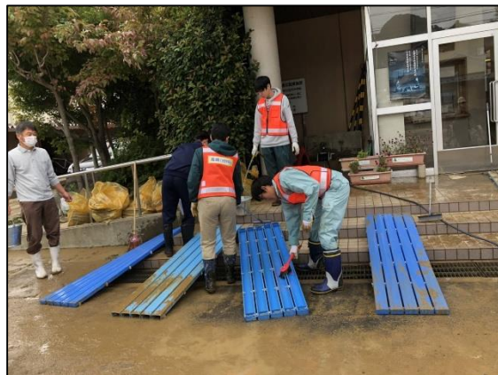
▲防災部による台風時による復旧作業の様子
